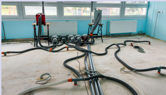
vysoušení podlah na 1. stupni
